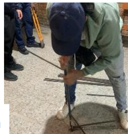
FIGURADO DE ACERO EN AMBIENTE DE FORMACIÓN
